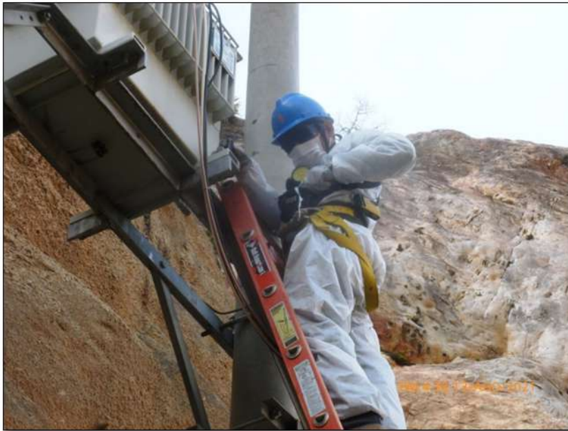
IMAGEN 14: Toma de datos y extracción de aceites de la Cámara de carga.
